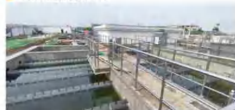
■ 阜阳七里铺污水处理厂
