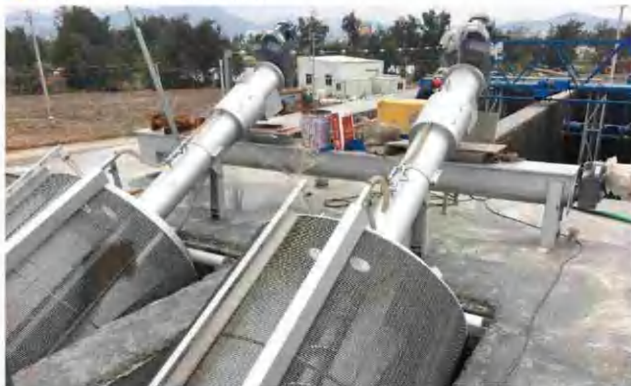
■ 新疆轮台污水处理厂回转齿耙格栅
