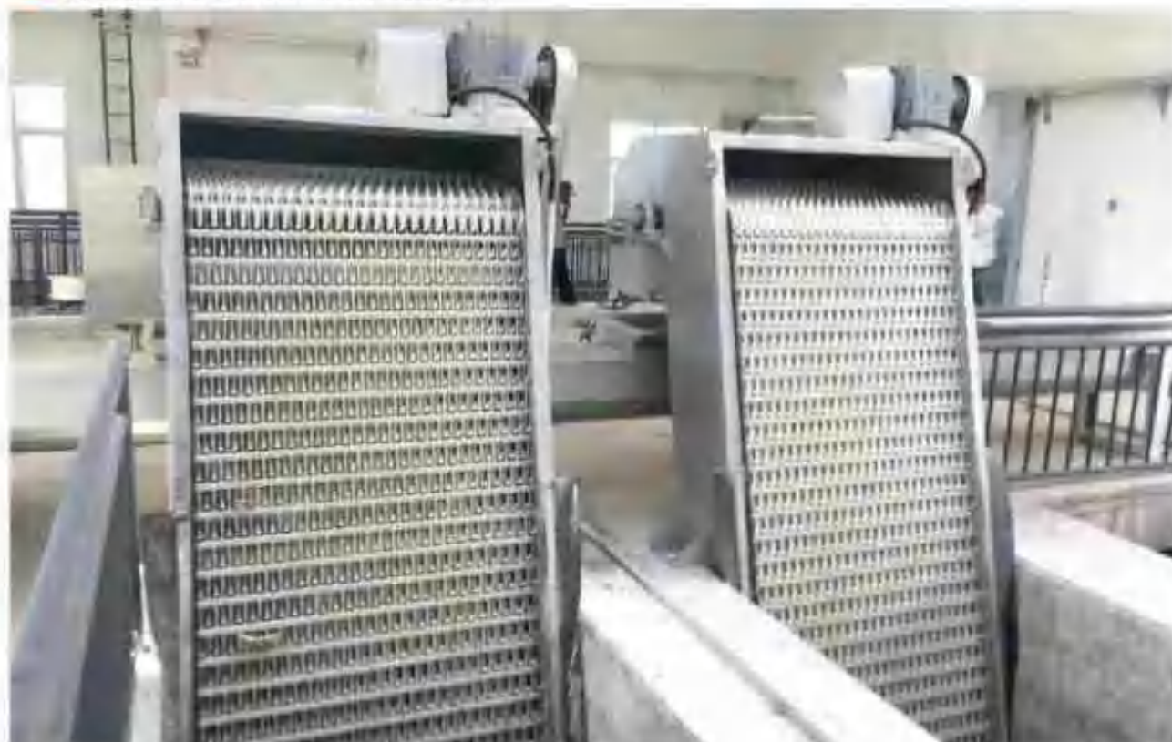
■ 新疆轮台污水处理厂回转齿耙格栅
